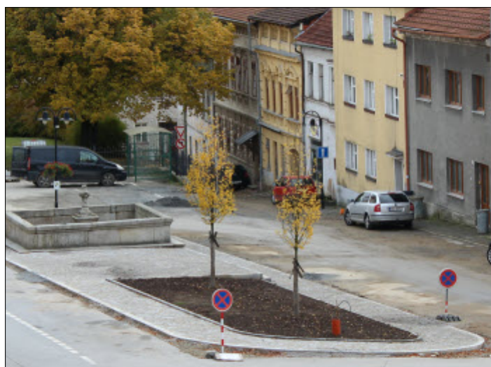
Další část upravovaného náměstí v Benešově nad Černou. Chodníky vydlážděny a osazeny nové stromky.
