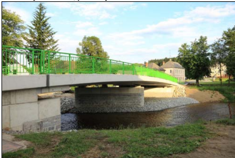
Od středy 27. 6. 2012 je v provozu zrekonstruovaný most přes řeku Černou v Benešově nad Černou.
